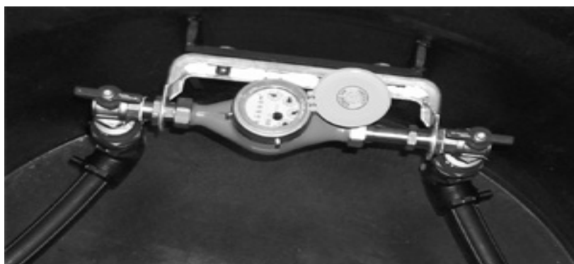
Figur 3. Exempel på mätarmonter i tät mätarbrunn
