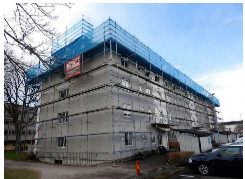
Nytt tak samt solceller monteras på Jacobs Gränd
