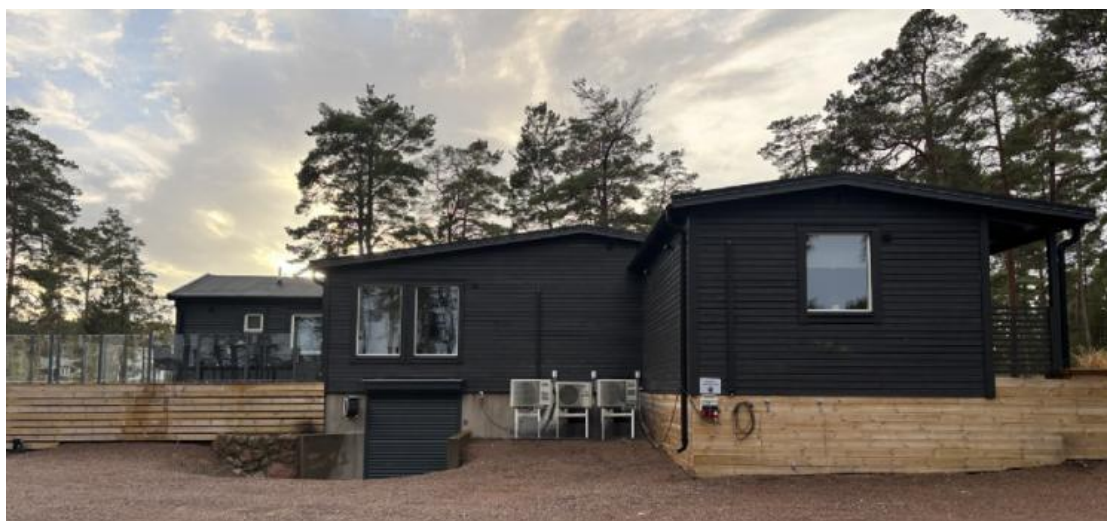
Byggnad vid Perchlodge
