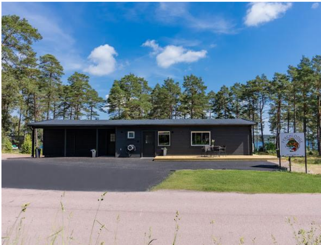
Befintlig byggnad vid Perchlodge
