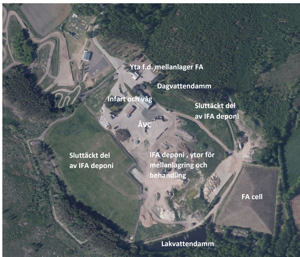
Figur 12. Översikt befintlig anläggning (från Lantmäteriet).
