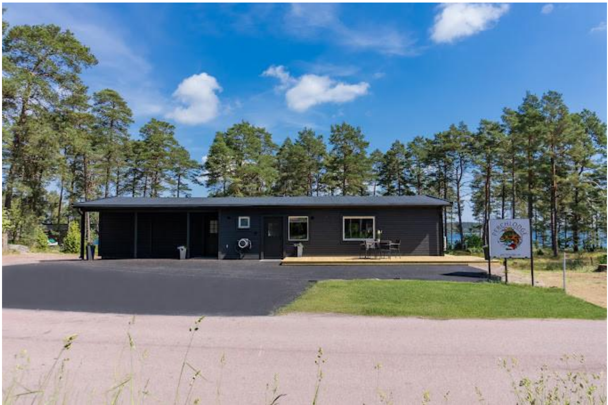
Befintlig byggnad vid Perchlodge
