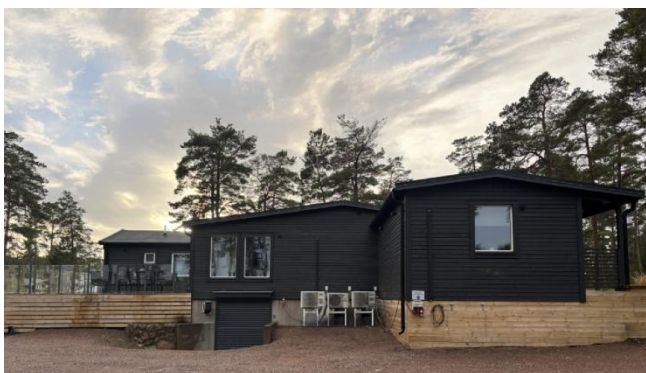
Byggnad vid Perchlodge
