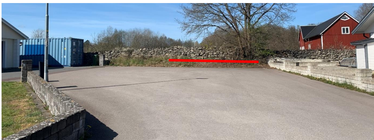
Den befintliga vändplatsen i slutet av Vetevägen. Röd markering i fotot visar ungefärlig sträckning för var en ca 7 meter bred öppning i muren behöver göras för att kunna förlänga gatan. Eken som står i anslutning till stenmuren är ungefär 20 cm i diameter, utan håligheter, och anses därmed inte vara skyddsvärt.
