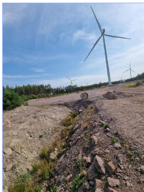
Dike som löper norr om vägen direkt norr om planområdet med korsande trumma under vägen från planområdet, foto taget mot öst (Dagvattenutredning, Sweco, 2023).
