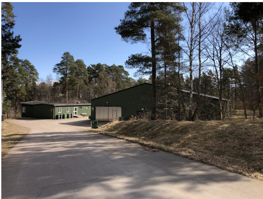
Figur 2 Den större byggnaden till höger är det inbyggda reningsverket, i den mindre byggnaden finns kontor och personalutrymmen.
