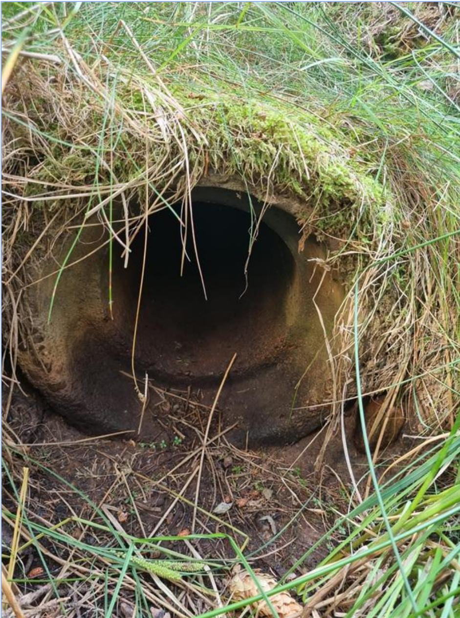
Figur 6. Betongtrumma under skogsväg, taget åt väst.
