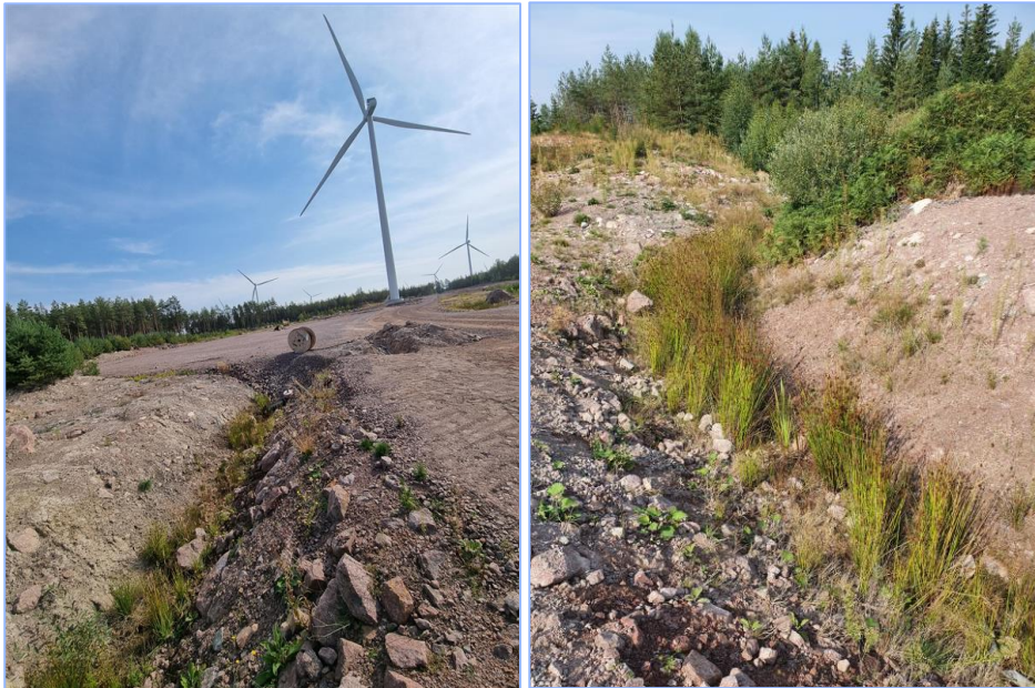
Figur 8. Vänster: Dike som löper längs väg söder om planområde med korsande trumma under vägen från sydost, foto taget åt ost. Höger: Diket svänger av åt nordväst, foto taget åt nordväst.
