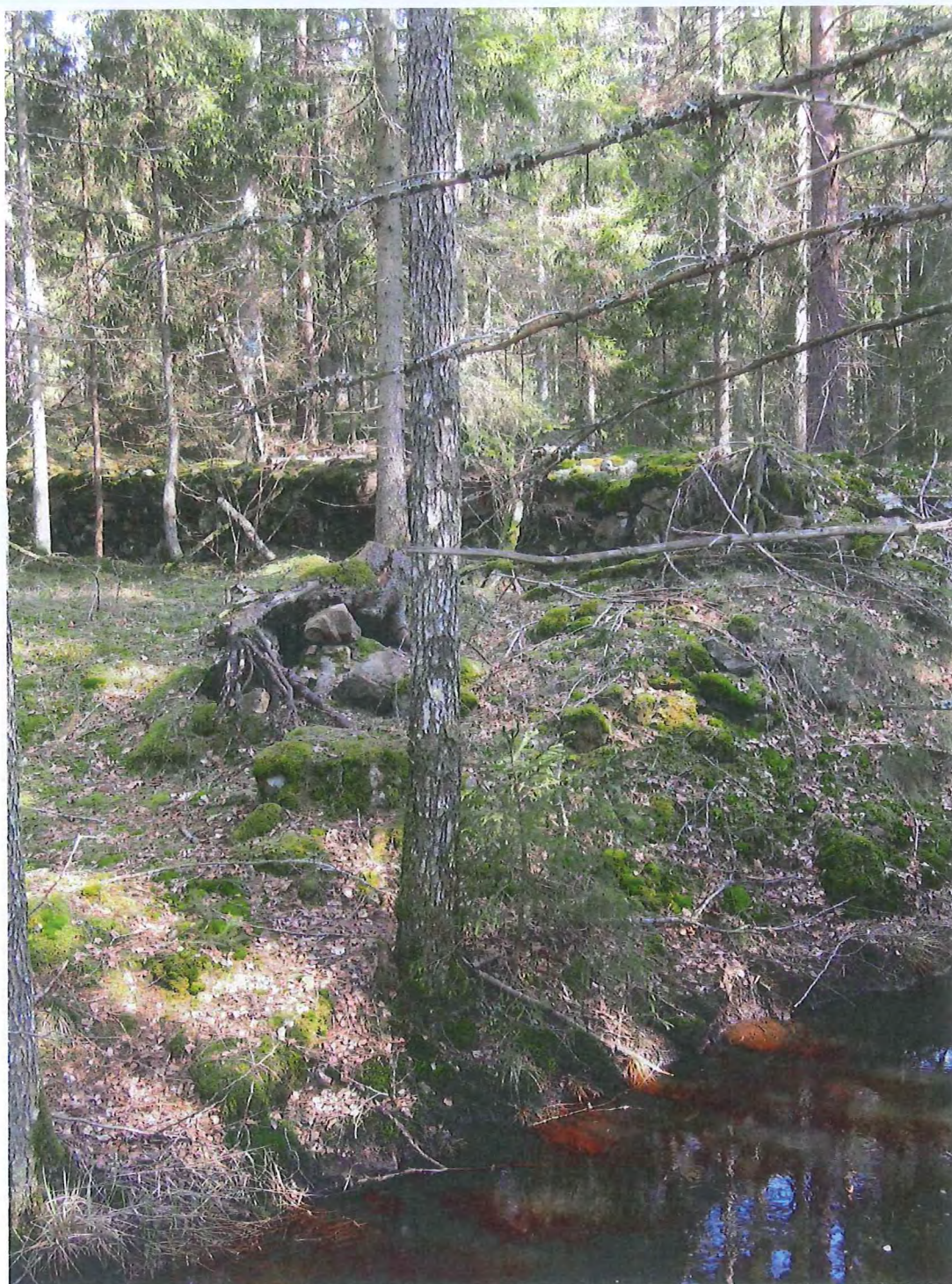
Bild 52. Den kvarliggande dammvallen norr om den rensade och fördjupade Örnebäck.
