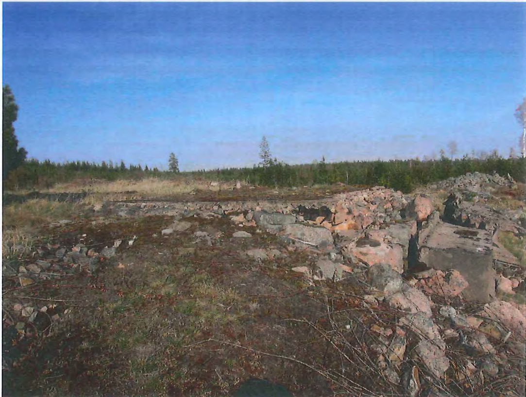
Bild 10. Ladugårdens södra gavel har börjat sönderfalla.
