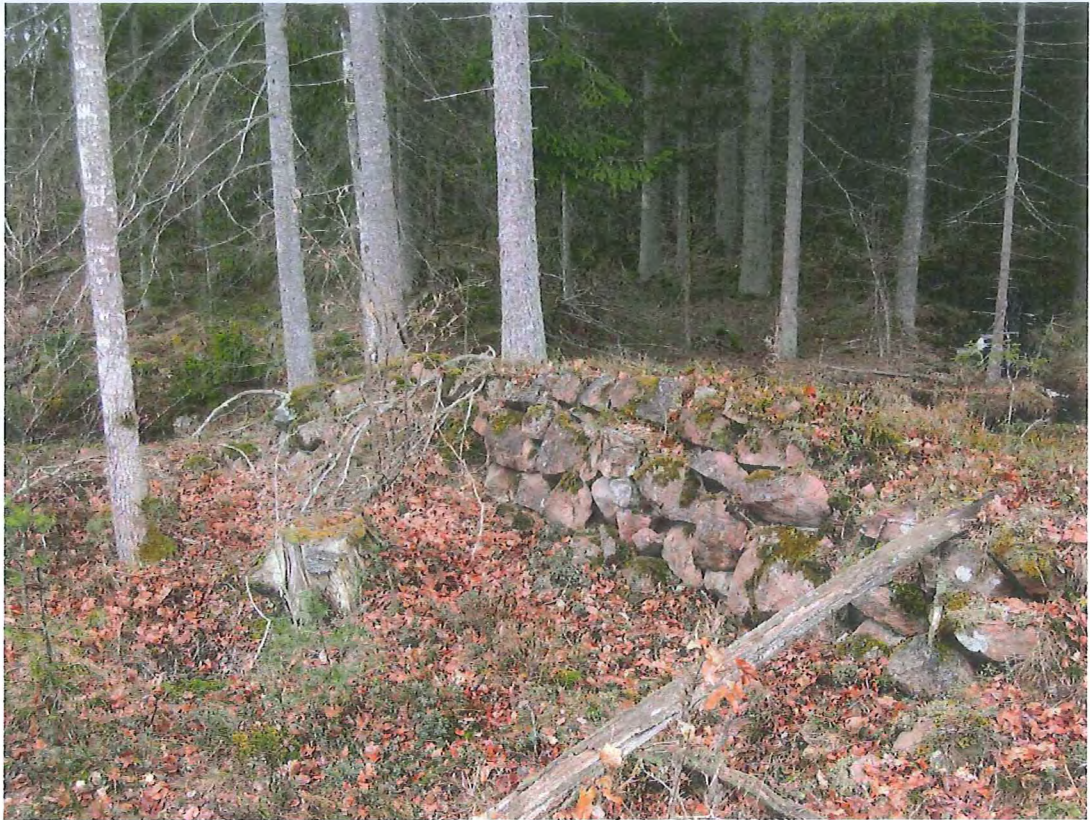
Bild 30. Östra delen av dammvallen.
