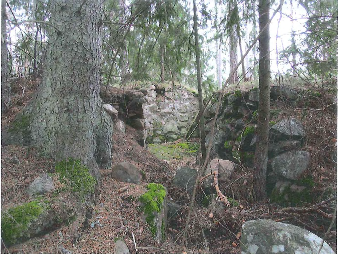
Bild 35. Jordkällaregrunden med sina höga, kallmurade väggar sedd från norr.
