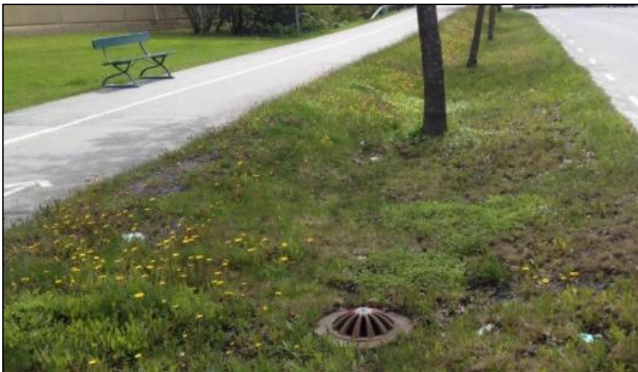
Figur 18. Exempel på svackdike (Sweco).
