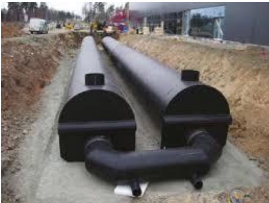
Figur 16. Rörmagasin (Stockholm Vatten och avfall, 2022)
