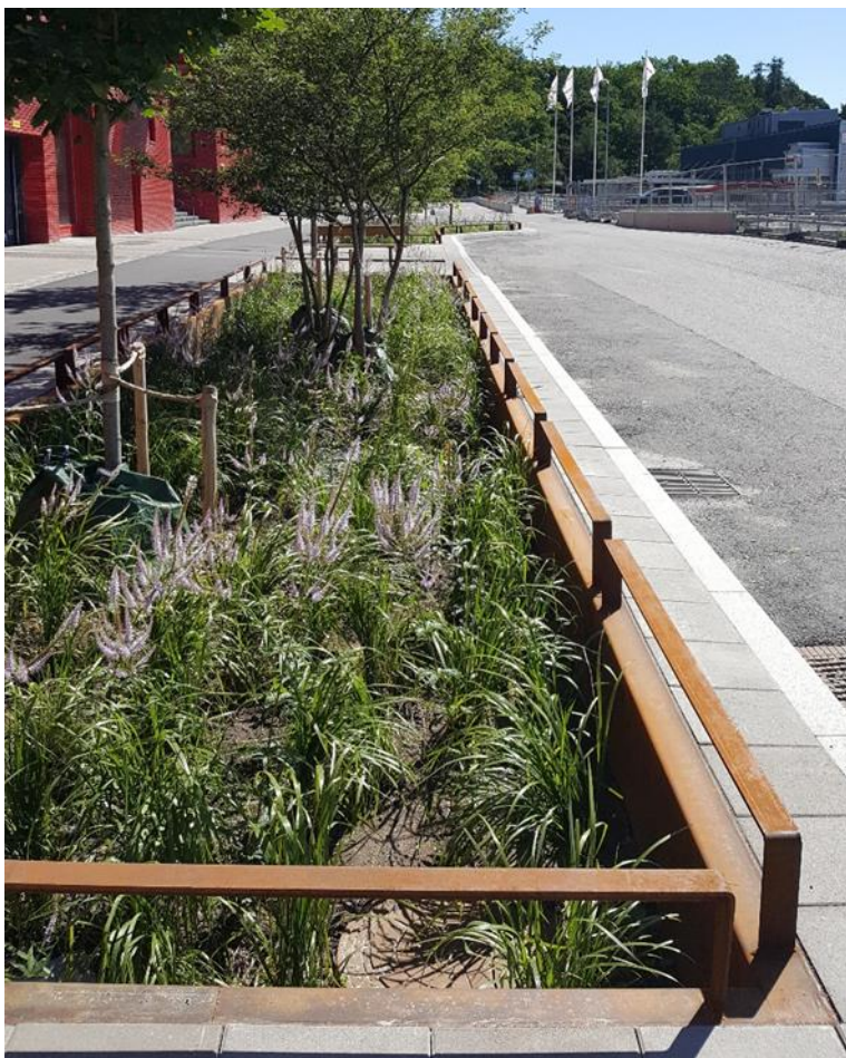
Figur 11. Regnbäddar kan planteras med både träd, buskar, perenner och prydnadsgräs (foto: Tyréns AB).
