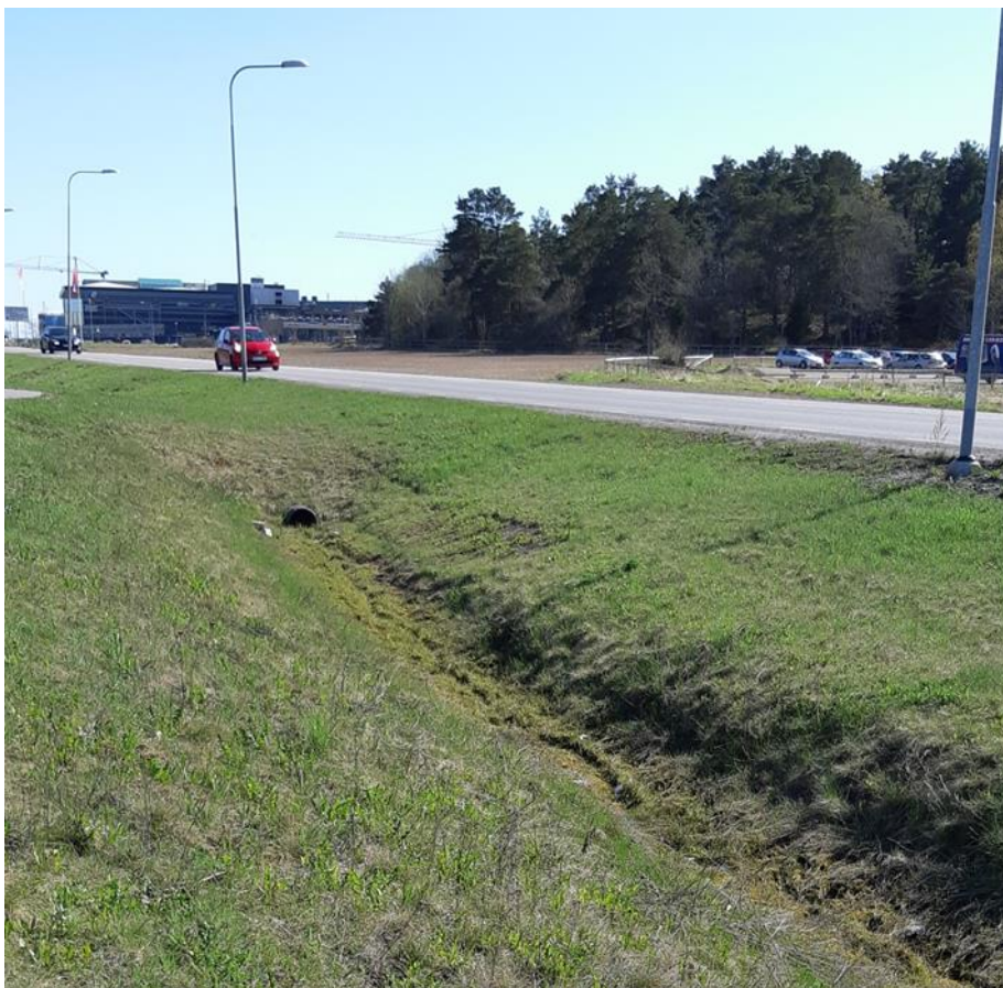
Figur 12. Exempel på svackdike (foto: Tyréns AB).
