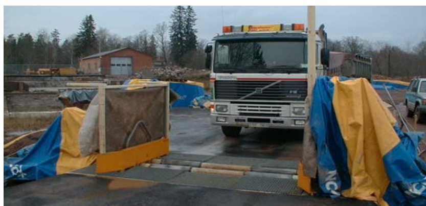
Hjultvätt, där lastbilarna rengjordes innan de lämnade området. Foto från Slutrapport: Efterbehandling av Jungnerholmarnas industriområde.
