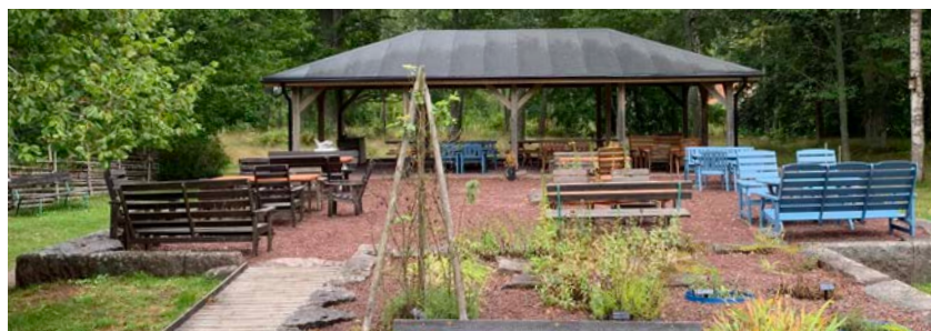
Bagarstugan och paviljongen i Patron Gustafs Trädgård. Paviljongen, som byggdes 2017, har byggts upp på den gamla stengrunden.
