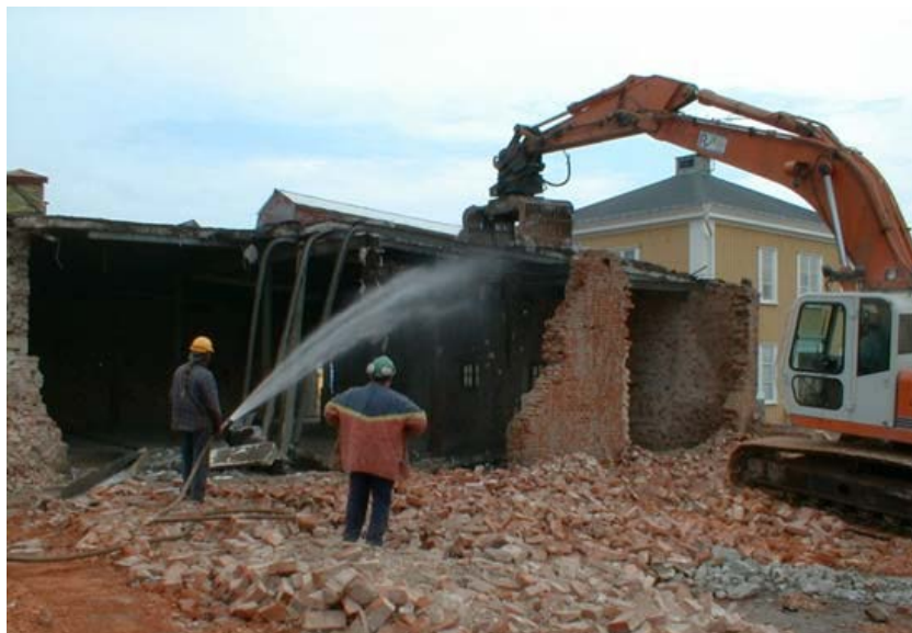
Rivning av Fabrik A. Foto från Slutrapport: Efterbehandling av Jungnerholmarnas industriområde.
