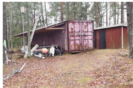
Förrådsbyggnad, container mm.
