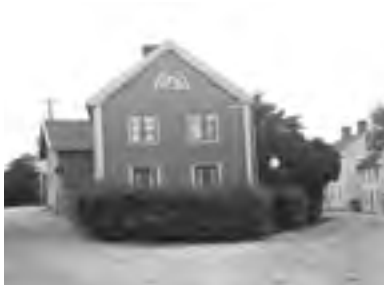
Rydvalls backe innan rivningen.
