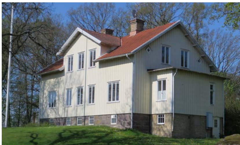
Befintlig bebyggelse (prästgården) på fastighet Ringblomman 1
