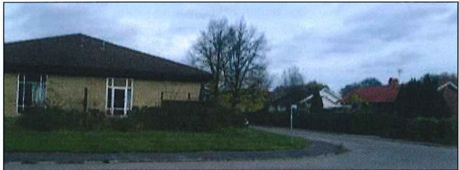
Vy norrut från korsningen Ljunäsvägen/Visborgsgatan. Kv. Tickans villabebyggelse syns till höger i bild.
