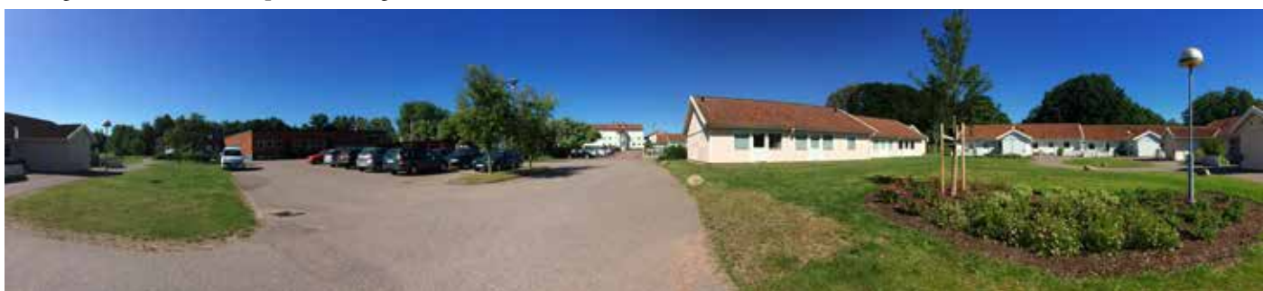
Vy från parkeringen / radhusen på en våning mot Torshaga och flerbostadshusen på tre våningar.
